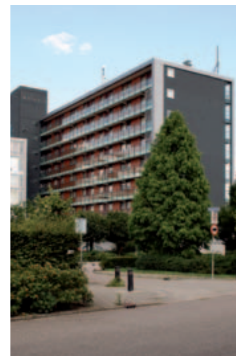
Wooncomplex De Windhond.
