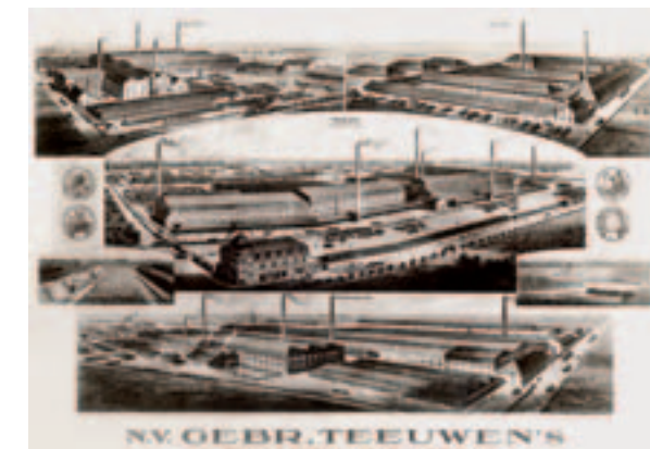
Dakpannenfabriek Gebroeders Teeuwen.
