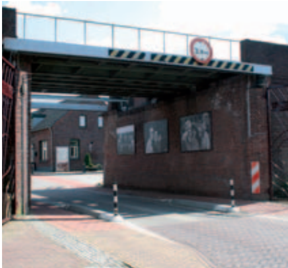
Viaduct D'n Baog.
