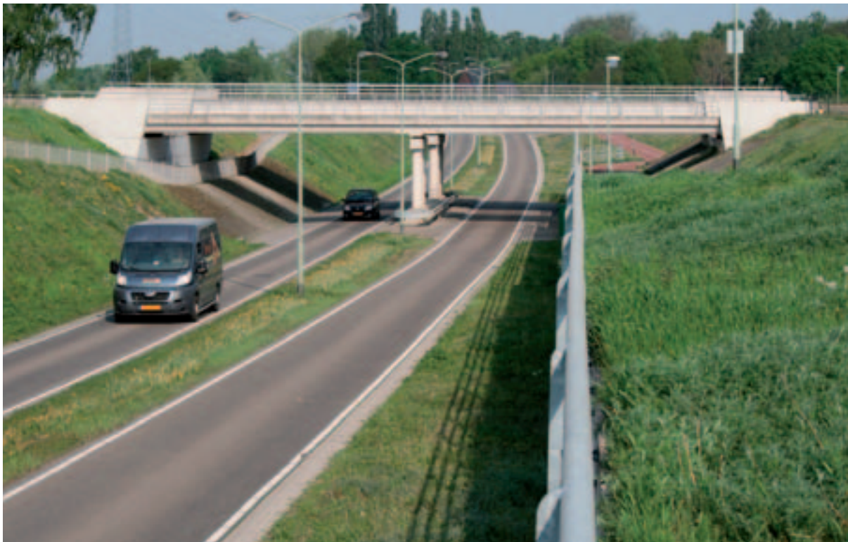
Viaduct over de Boxhoverweg.
